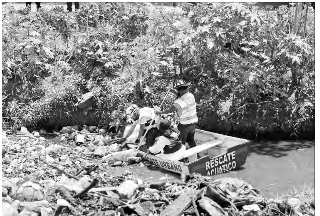
▲ Trabajos de desazolve en el canal Cartagena, en los límites de Ecatepec y Coacalco, estado de México, donde el lunes grupos de
