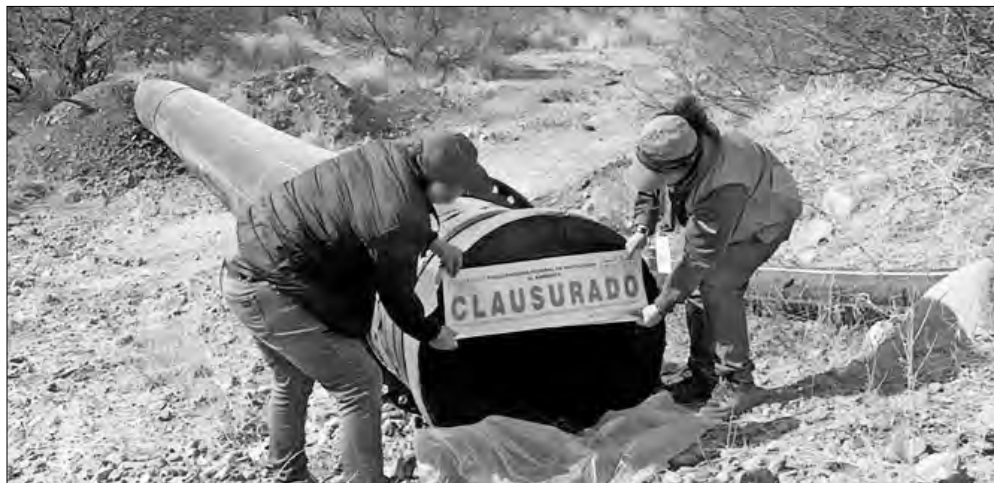
▲ Clausura de manera temporal del ducto de 10.5 kilómetros que sin permisos trasladaba
