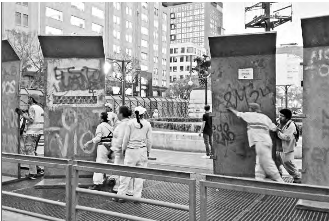
▲ En el Centro comenzó la colocación de vallas metálicas. Foto Jorge Ángel Pablo García
