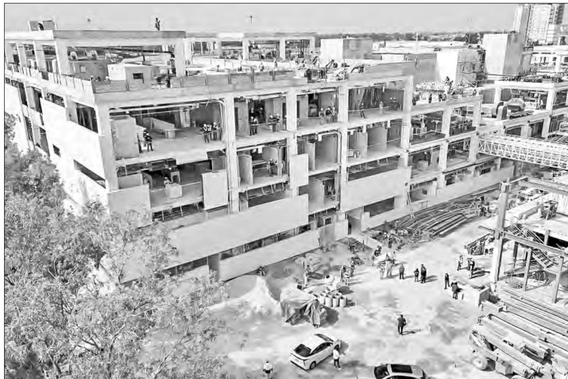
▲ La jefa de Gobierno, Clara Brugada, y el director del Seguro Social, Zoé Robledo, recorrieron las obras del inmueble de 48 mil 200 metros cuadrados
