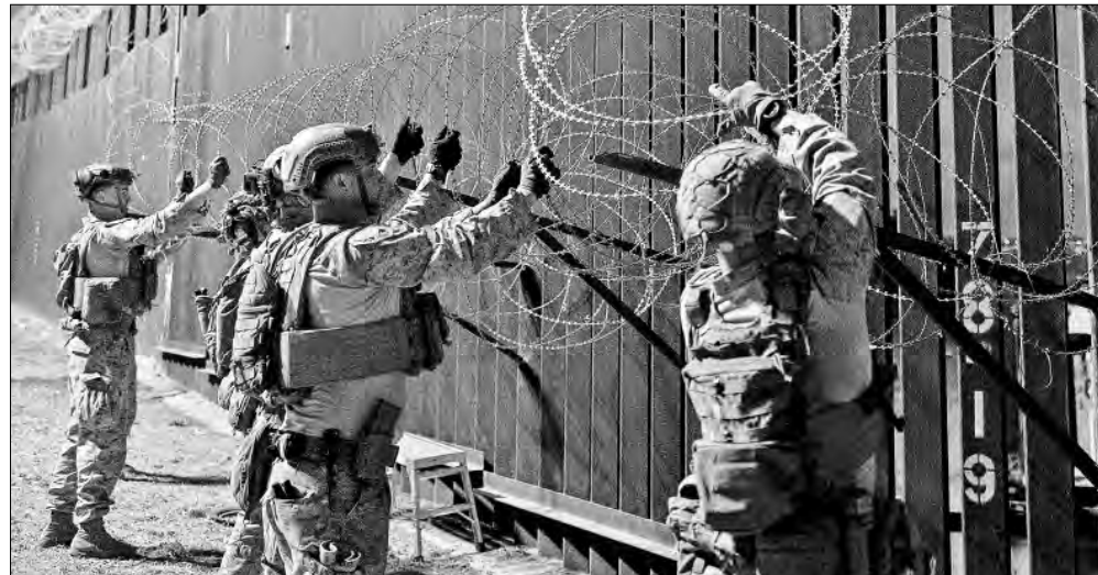
▲ Marines instalan alambre de concertina a lo largo de la frontera con México, cerca de San
