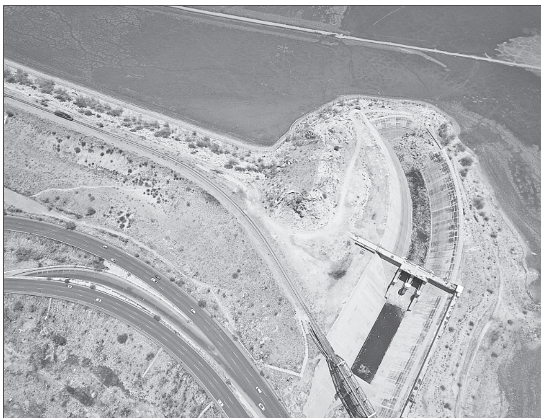
▲ Aspecto de la presa Abelardo L. Rodríguez, en el municipio de Hermosillo, Sonora, la cual está totalmente seca, debido al estiaje que padece la entidad desde 2022. Foto Cristina Gómez Lima
