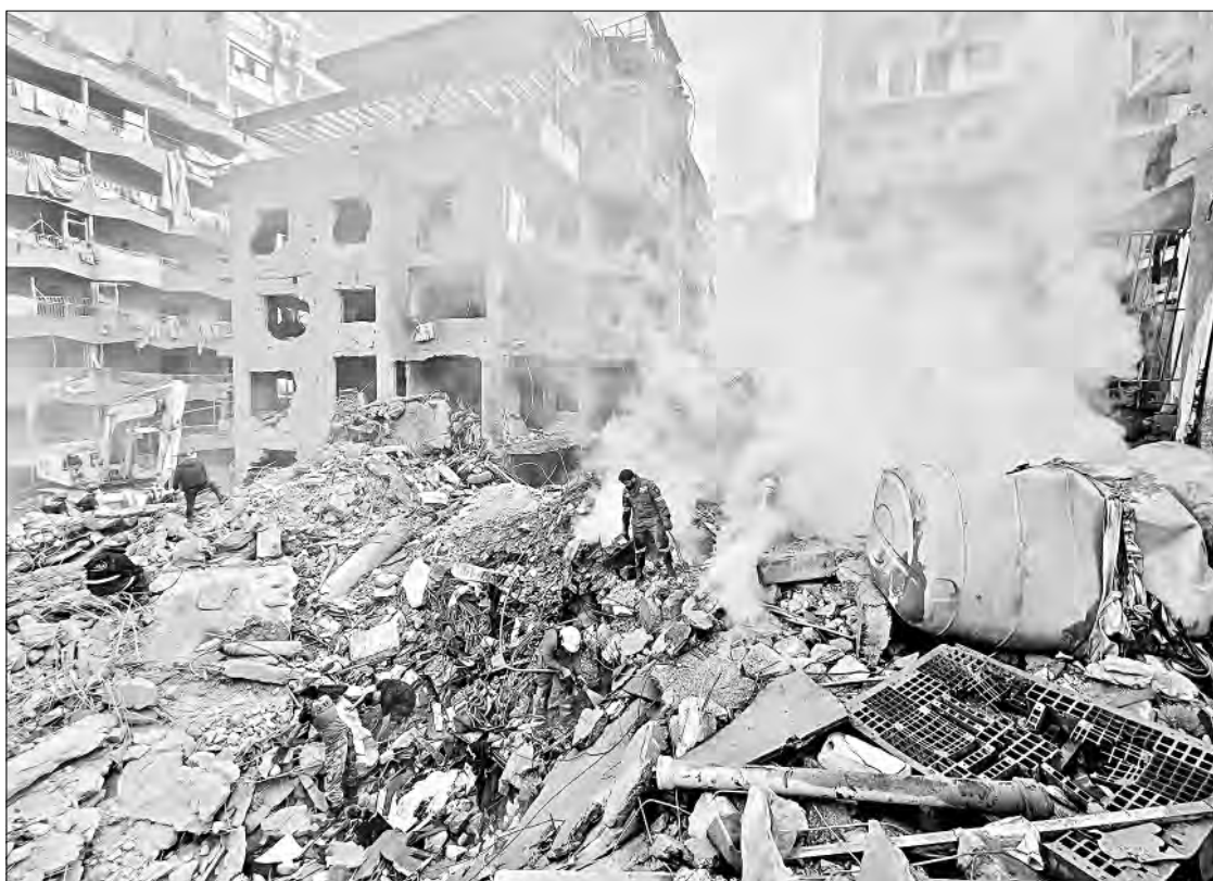
Rescatistas buscan víctimas entre los escombros del edificio destruido en el barrio de Basta el Faouqa, en Beirut. Foto Ap
