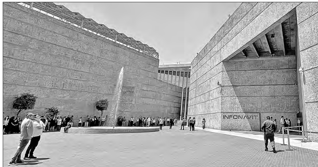
▲ Dirigentes sindicales y patronales se oponen a que el Instituto del Fondo Nacional de la Vivienda para los Trabajadores participe directamente en la construcción. Foto La Jornada
