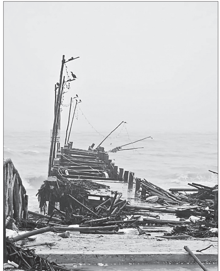
▲ El principal muelle de Chelem, Yucatán, quedó destrozado tras el impacto del huracán Milton, el cual provocó ráfagas de viento e intenso oleaje. Foto tomada de la página de Facebook Sol Yucatán
