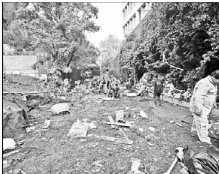
▲ Empleados del Sacmex y de Protección Civil acudieron a realizar la limpieza de la zona. Foto Yazmín Ortega Cortés
