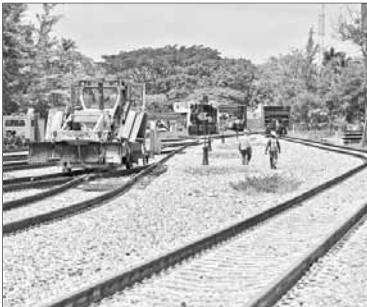
► Detalle de la estación de Ixtepec. Foto Víctor Camacho
