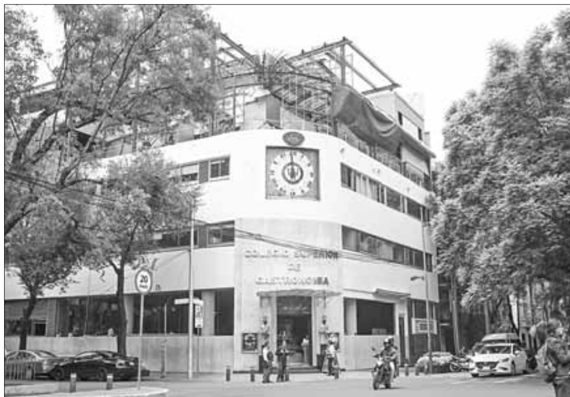
▲ En el edificio ubicado en Sonora 189, colonia Hipódromo, que alberga al Colegio Superior de Gastronomía, se trabaja a marchas forzadas para
