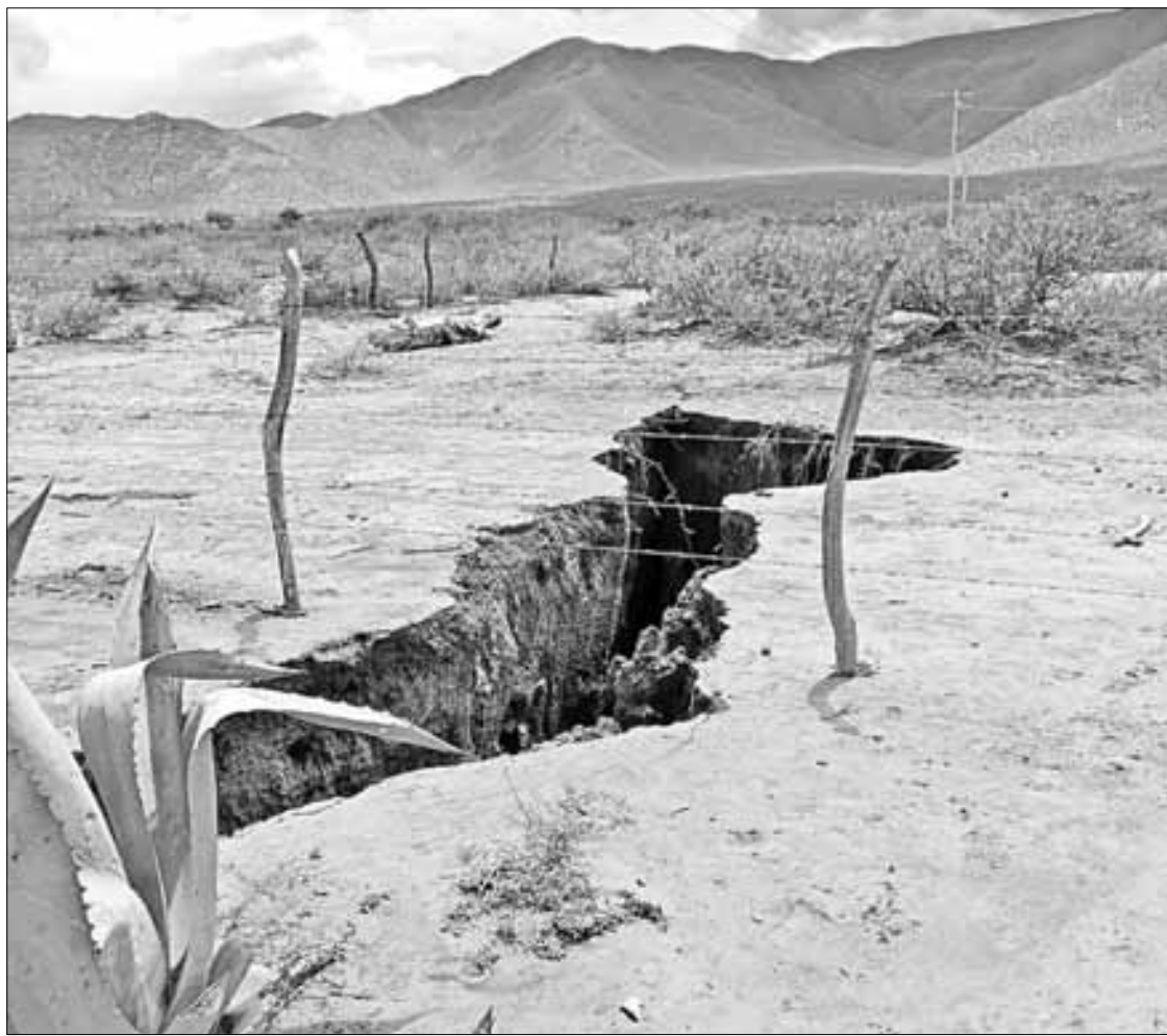
▲ Pobladores de la localidad Congregación El Carmen, y los ejidos Vázquez y San Juan, en el municipio de Tula, Tamaulipas, reportaron la aparición de fisuras el fin de semana después de los recientes aguaceros que azotaron la entidad por la tormenta tropical Alberto . Foto La Jornada
