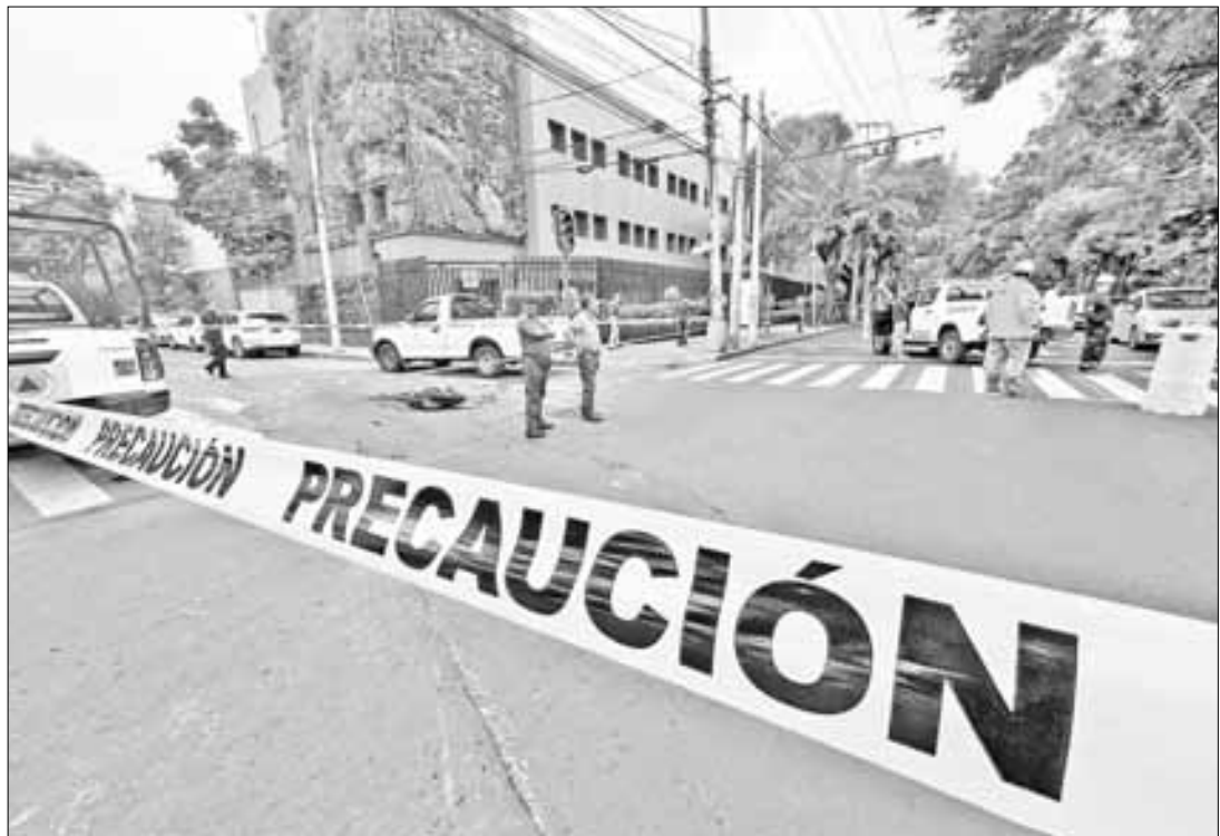
▲ Un gran agujero se formó en la intersección de la calle Moctezuma y avenida Miguel Ángel de Quevedo, en la demarcación territorial de
