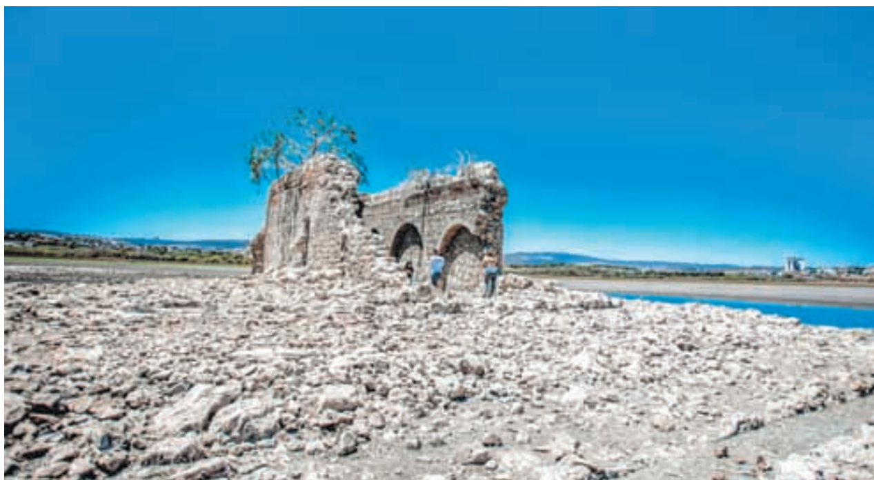
▲ La desecación de la presa El Palote, en León, Guanajuato, dejó al descubierto construcciones antiguas. Foto Cuartoscuro
