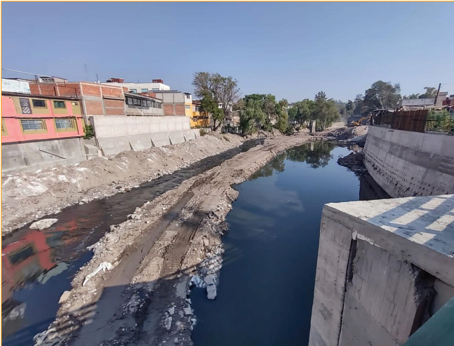
Cauce del río Tula, modificado por las obras de la Conagua
