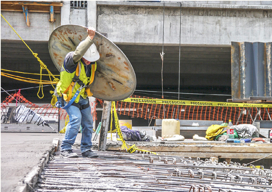
De la serie Albañiles . Foto: Guillermo Bellinghausen Zinser
