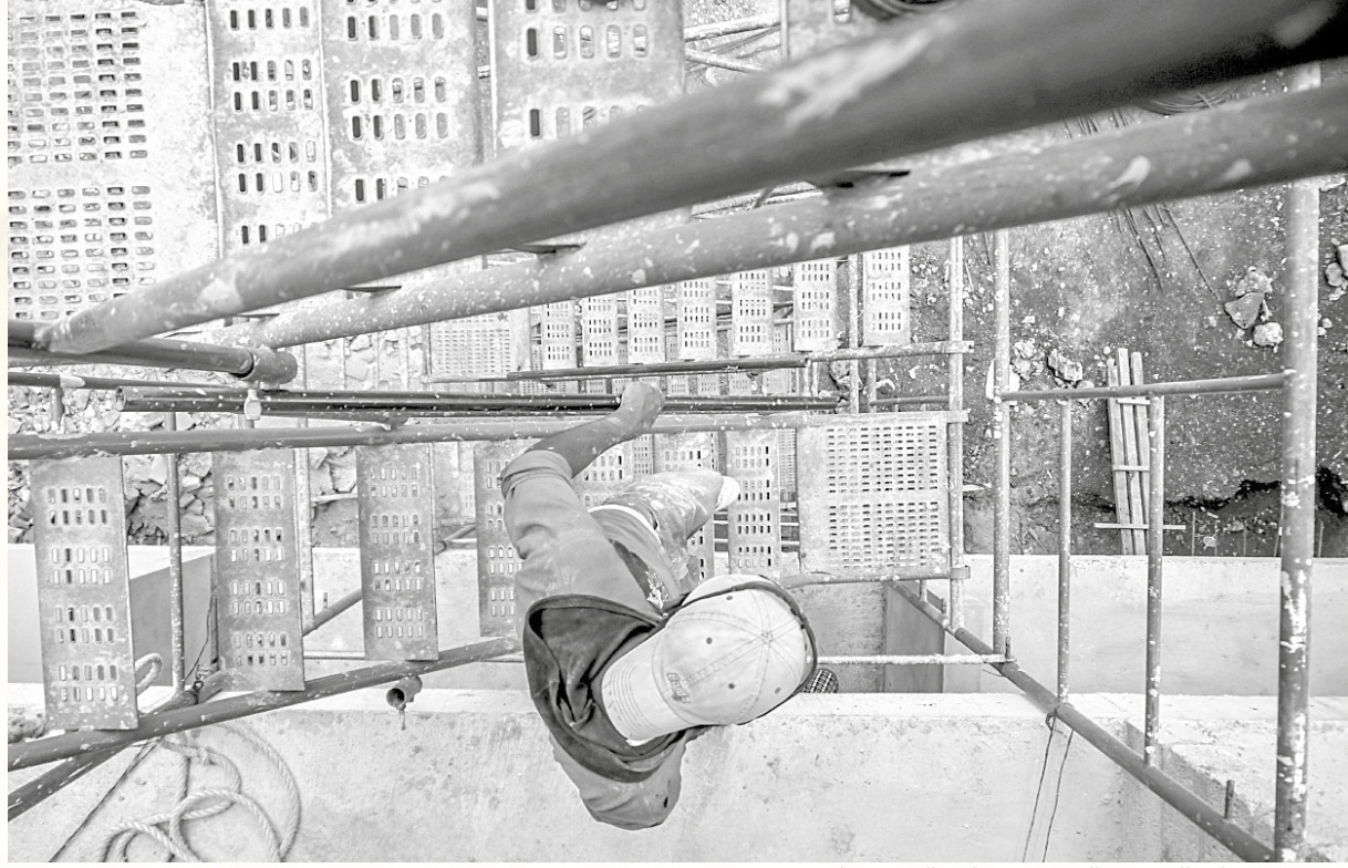
De la serie Albañiles . Foto: Guillermo Bellinghausen Zinser
