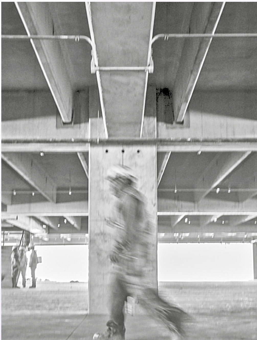
De la serie Albañiles . Foto: Guillermo Bellinghausen Zinser
