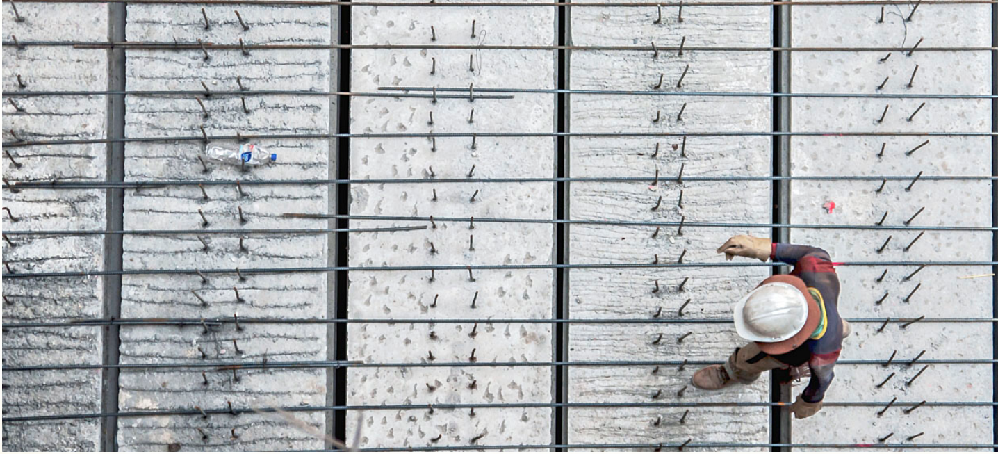
De la serie Albañiles . Foto: Guillermo Bellinghausen Zinser
