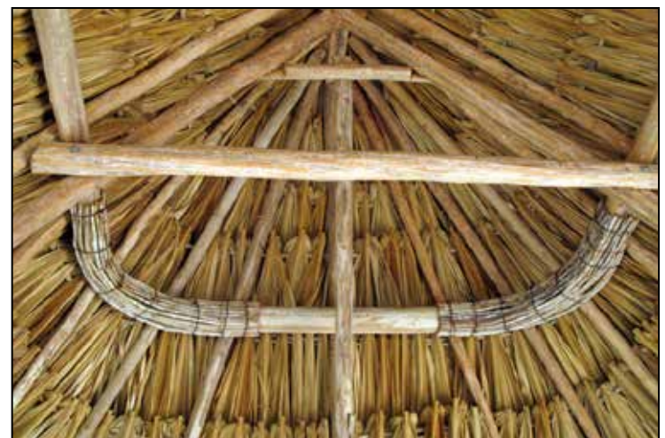
Vista del interior de un techo de palma de huano ( Sabal yapa ) en una casa maya de Quintana Roo. Fotografía: José Antonio Sierra Huelsz
