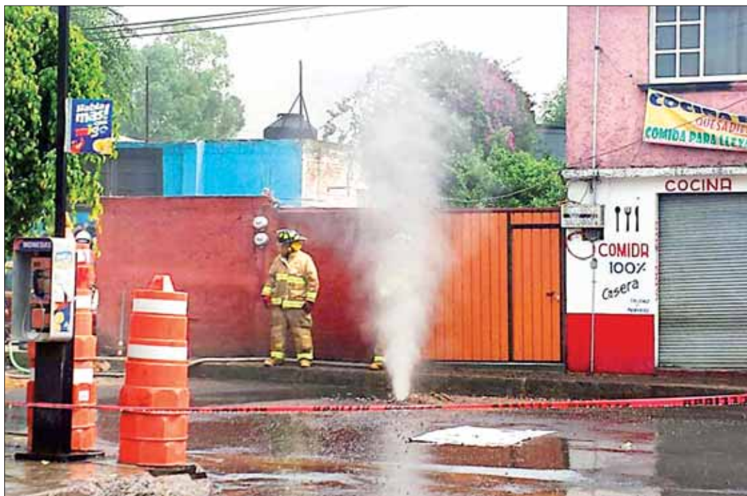
Más de mil personas fueron desalojadas luego de que una excavadora de la empresa Gas Natural rompió un ducto de alta presión en la calle Miguel Hidalgo, esquina con Central. El percance ocurrió a las 9 horas y afectó seis manzanas y cinco escuelas. La expulsión del combustible, que alcanzó tres metros de altura, fue controlada cuatro horas después por autoridades y personal de la firma ■ Foto Alfredo Domínguez
